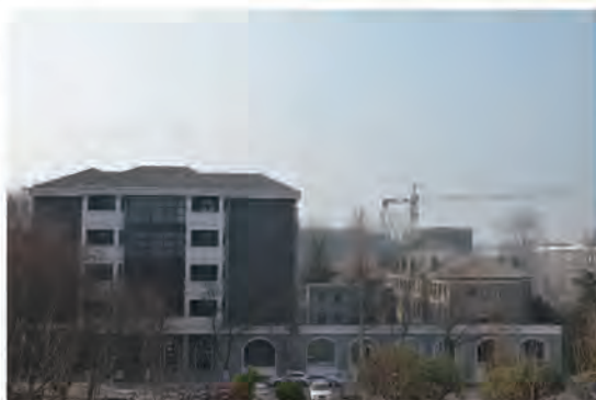
语科院建筑群（10000平方米独立空间）
